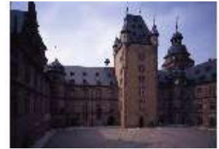
Asch.I, Innenhof mit Bergfried, DE003867, BSV-
