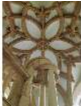
Asch.II, Treppenspindel und Bogenrippengewölbe, südl. Treppenturm, DI030744, BSV-
