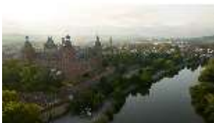
Asch.I, Luftaufnahme von W, DI024570, BSV-
