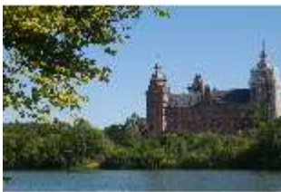
Asch.I, Südfassade, DI013980, BSV-
