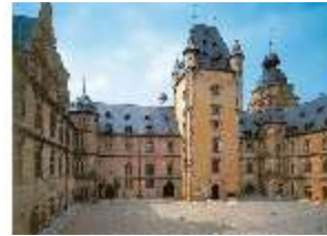
Asch.I, Innenhof mit Bergfried, DE001181, BSV-
