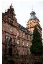
Asch.I, Hauptportal mit Ostturm, DI024553, BSV-
